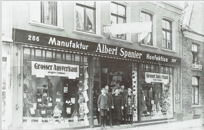
Wohn- und Geschäftshaus der Fam. Albert Spanier in der Monrestraße 22
